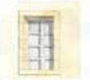
L'encadrement de la fenêtre est en saillie par rapport au reste du mur. Celui-ci était destiné à être enduit.
