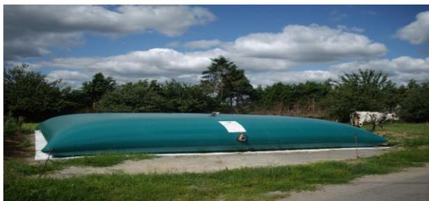
Vue de la réserve de 120.000 litres d'eau. Taille au sol avant remplissage 12 mètres sur 10 mètres.
